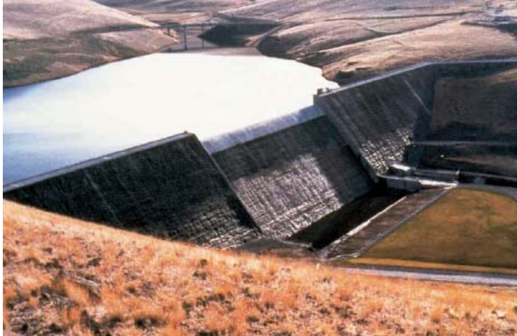
Fotografía 2: Presa de Willow Creek (Estados Unidos, 1983).
