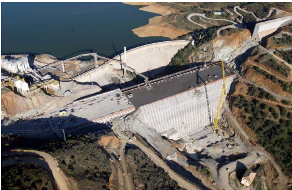
Fotografía 18: Presa de la Breña II
