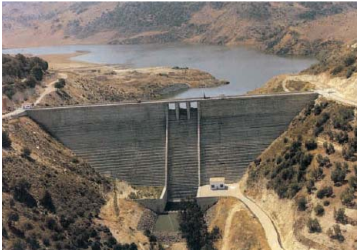
Fotografía 7 : Presa de Puebla de Cazalla
