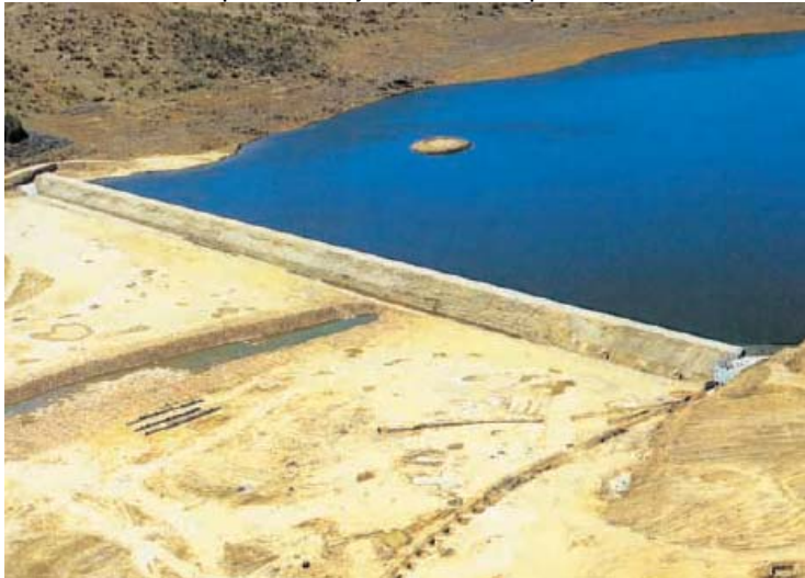
Fotografía 13: Presa de Guadalemar
