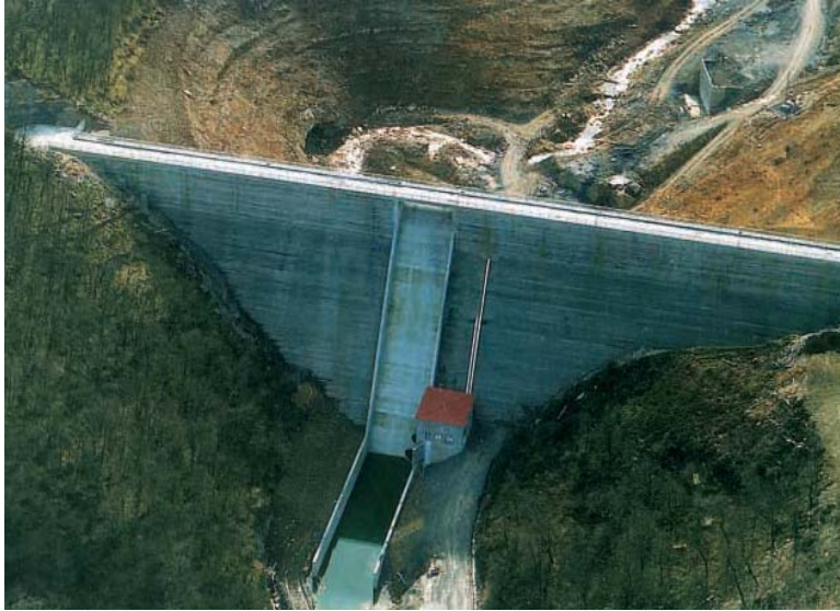
Fotografía 6: Presa de Maroño
