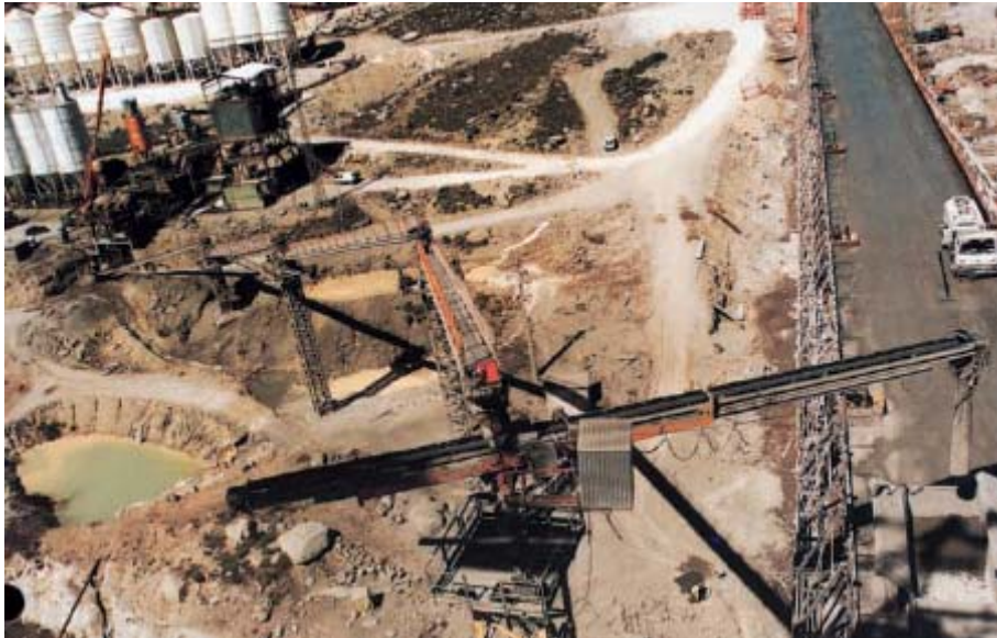
Fotografía 10. Construcción presa de Cenza
