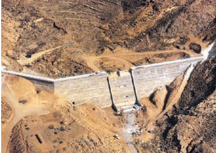
Fotografía 9: Presa de Belén-Cagiuela
