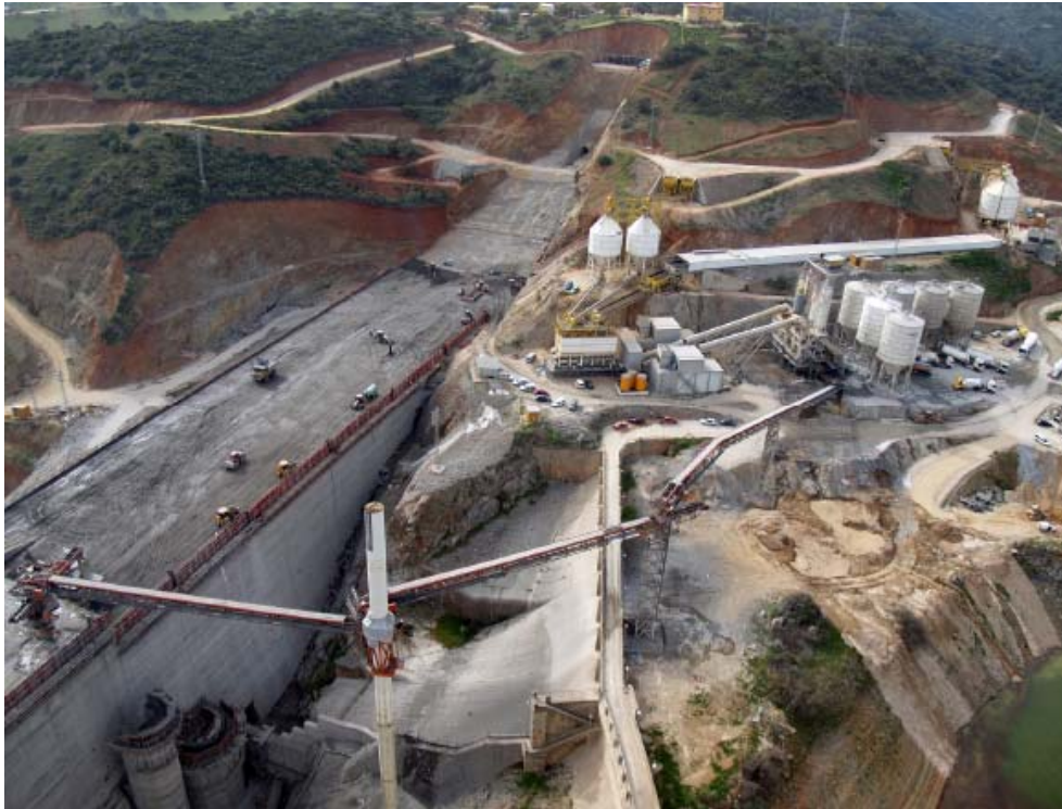
Fotografía 17: Presa de la Breña II
